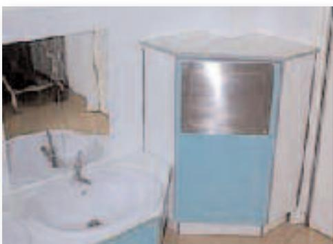
Il s'agit d'un système indépendant (caisson abritant les poubelles) intégré dans le système de ventilation générale et qui permet d'assurer un confort olfactif dans des locaux pollués par les odeurs de couches notamment, en l'installant au plus près de la source pour éviter leur introduction ou leur mélange dans l'air local. Ce dispositif permet d'éviter l'usage de désodorisants et autres parfums d'ambiance particulièrement toxiques. Il est en général fabriqué sur mesure.
